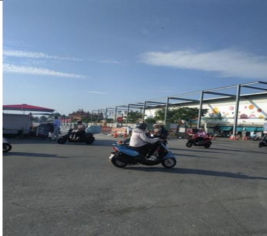
照片 19：此照片為紅毛溪的下游，紅毛溪的香榭大道工程已經施工了。
